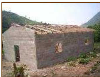
Instalación del techo
