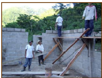
Levantamiento de paredes
