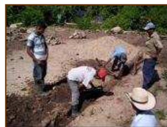
Inicio de la obra
